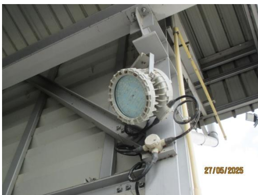
รูปที่ 3-7 อุปกรณ์ ประเภทป้องกันการระเบิด (Explosion Proof)
